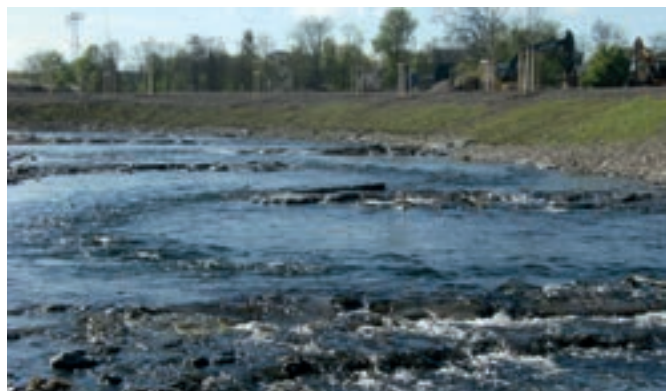
Das Flussbett der Gera nach dem Abbruch des Wehres Gispersleben.
